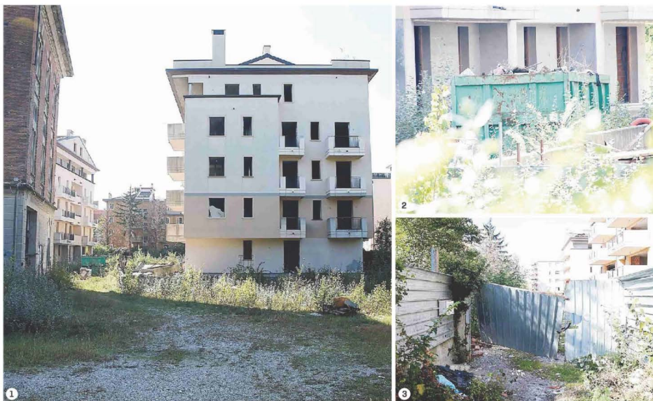
Una delle tre palazzine abbandonate nel grande cantiere all'angolo tra viale San Marco e via Sansovino; 2) Un contenitore di rifiuti all'interno del cantiere. Negli appartamenti spesso la polizia locale trova giacigli di fortuna; 3) Il cancello d'accesso all'area divelta. Altri passaggi sono stati aperti nella recinzione FOTO PORCILE
