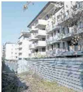
DEGRADO Il cantiere abbandonato di via Sansovino
